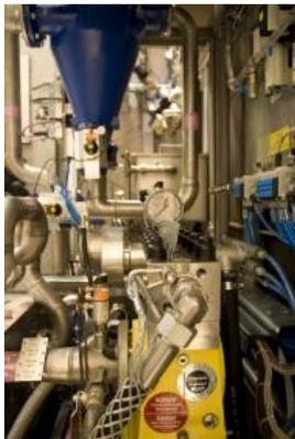
Durch die Integration eines Frequenzumrichters arbeitet die Druckerhöhungspumpe nun bedarfsabhängig verbraucht dadurch deutlich weniger Energie.
